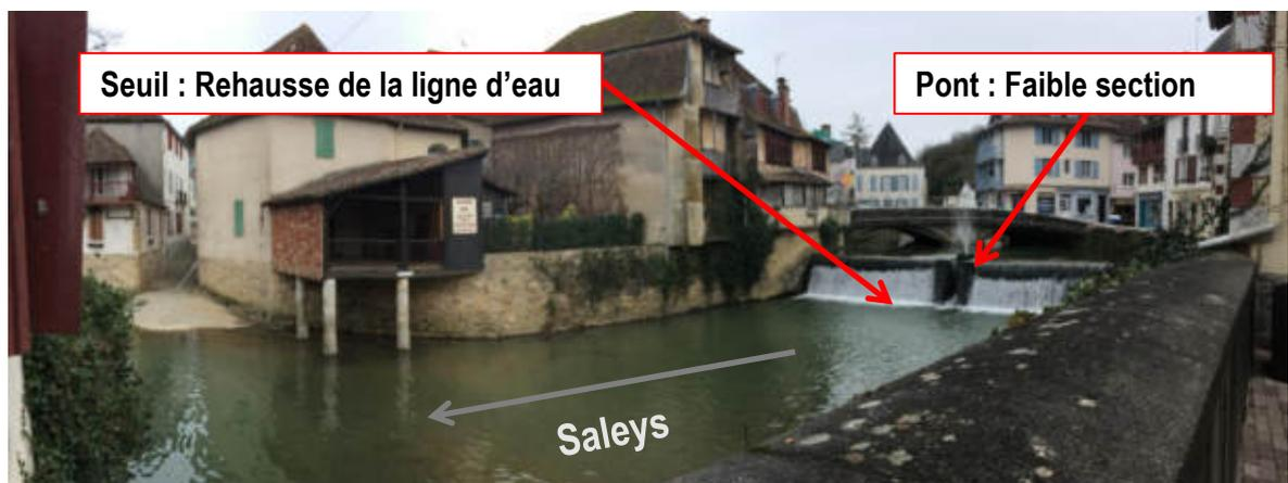
FIG. 12. Ouvrages du pont de la lune
