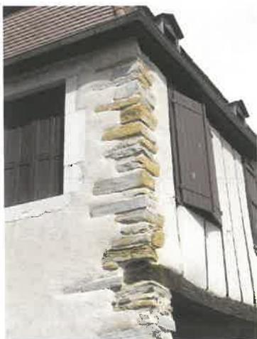
Ici le chaînage d'angle aurait dû être enduit ; la pierre n'est pas faite pour être vue ; d'ailleurs l'aspect de cette pierre contredit le caractère fini de la pierre d'encadrement de la fenêtre.
