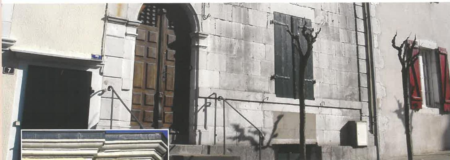
Enduits, avec encadrements de pierre, façades en pierre de taille : l'architecture béarnaise est une architecture constituée de fortes maçonneries. L'essentiel de la maçonnerie est constitué de pierres extraites brutes, sans retaille, des moellons de pierre, puis enduites ; seuls les encadrements et les bandeaux sont maintenus en pierre apparente. Quelques immeubles présentent des façades toutes en pierre de taille, notamment les demeures nobles et l'architecture de la Belle-Epoque.
