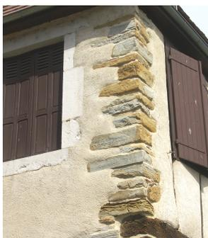
Il ne fait pas faire apparaître les chaînage d'angle en moellon (pierres non taillées pour être vues). Ces angles doivent être enduits.
